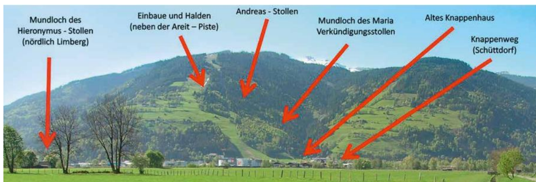
Die Lage der ehemaligen Bergbaue im Kupfer- und Schwefelerzrevier zwischen Zell und Aufhausen. © Foto und Graphik: Rainer Hochhold
